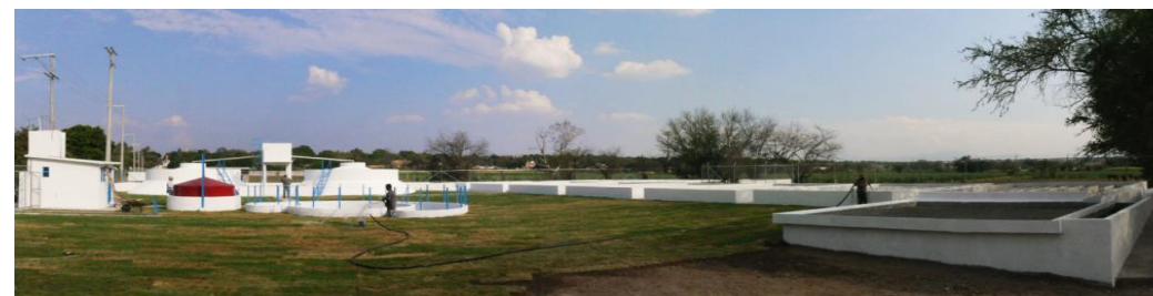
Planta de Tratamiento Municipal
